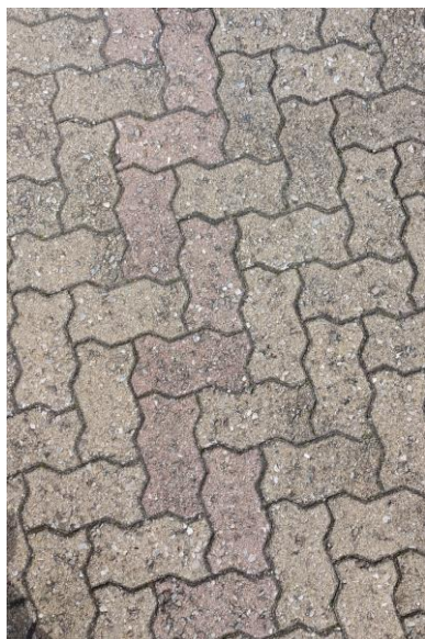
Particolare della posa della pavimentazione su piazza IV Novembre
